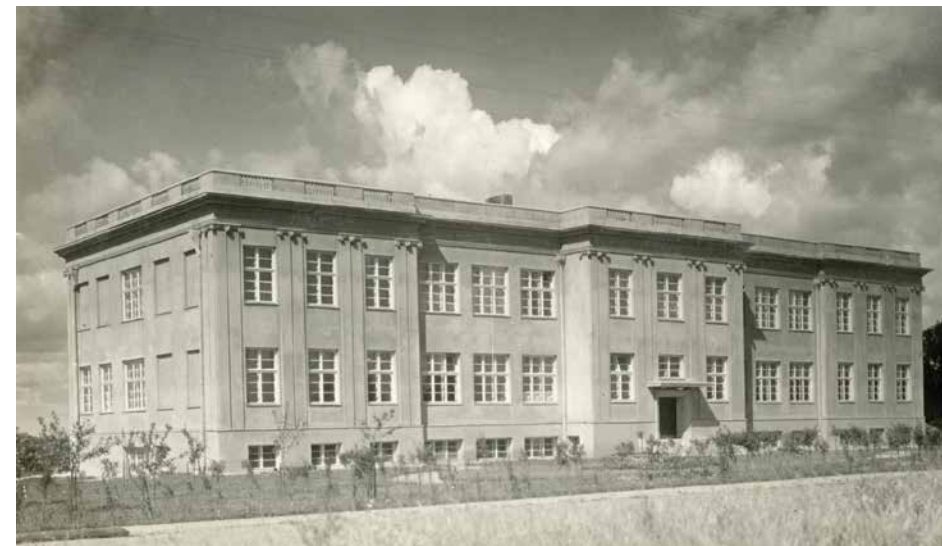
Biržu ģimnāzijas ēka, uzcelta 1931. g. pēc arhitekta Vītauta Landsberģa-Žemkalņa projekta.
